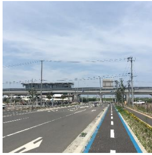
JR 坂元駅付近 この辺りにも津波が来たので、 10mの高さの高架駅になりました。
